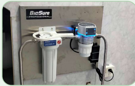
Maintenance préventive des canalisations d'eau
